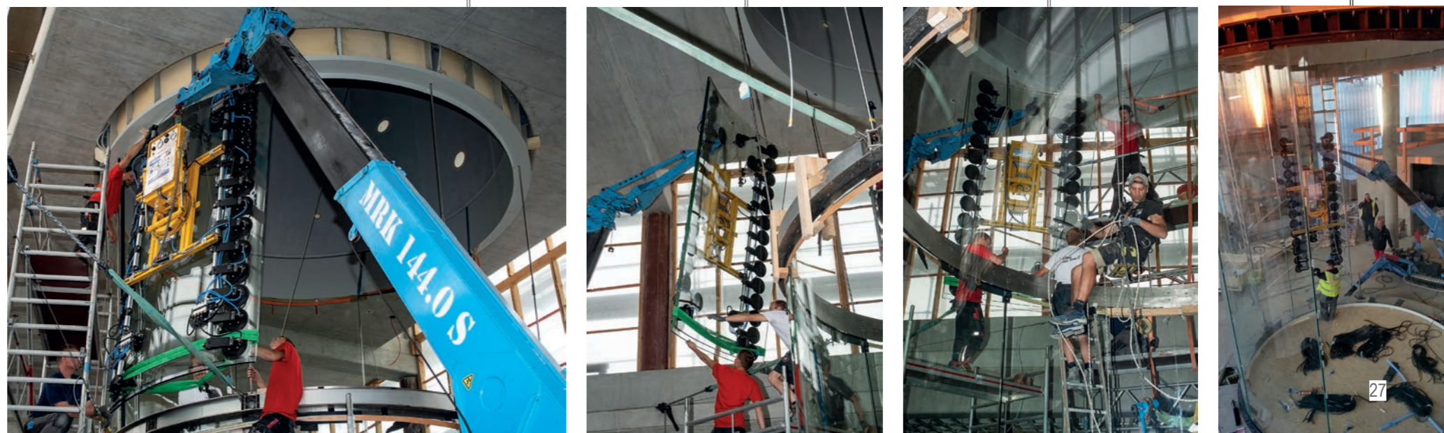
Macaraua de montaj MRK 144.0 S și instalația de sucțiune vacuumică VSG 1000 KR la vitrarea Flight Chamber
