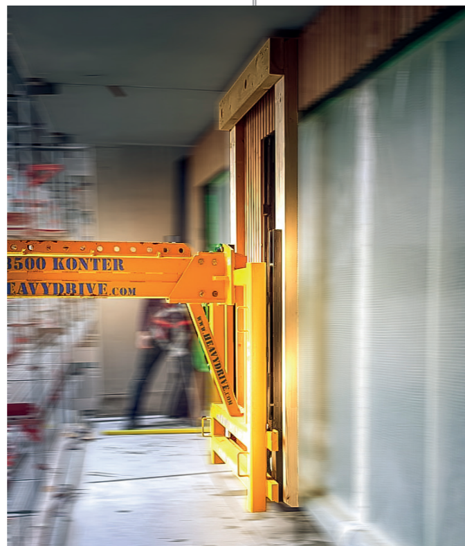
Transportarea elementului de fațadă cu contra-traversa VSG Konter și furca special dezvoltată.
