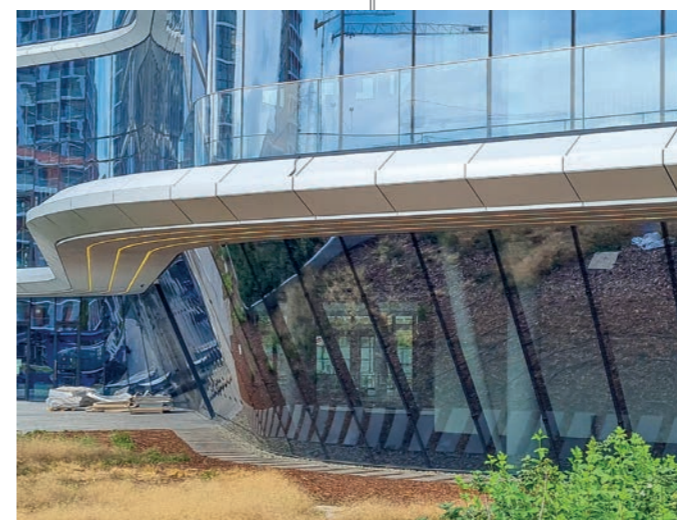
Intervenția Heavydrive la campusul MOL din Budapesta. Montarea de panouri de sticlă înclinate spre exterior.
