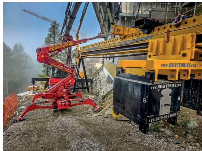
Panoul de sticlă va fi ridicat pe fațada înclinată cu ajutorul instalației Heavydrive.
