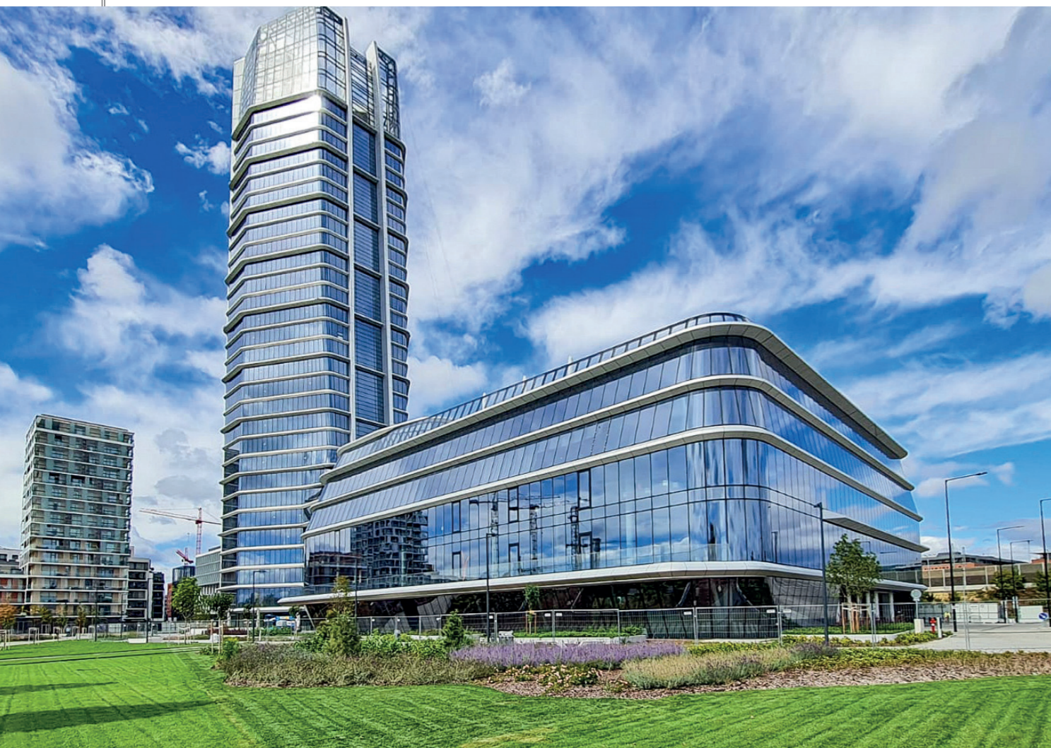
Campusul MOL din Budapesta: Amprente la sol diferite, panouri de sticlă cu diferite curburi.
