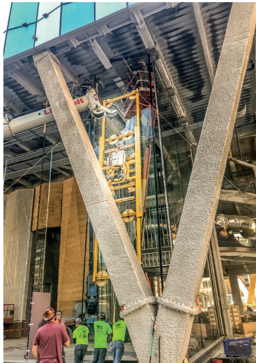
Elementul de sticlă este ridicat în spatele coloanei cu o instalație de montare a sticlei modificată
