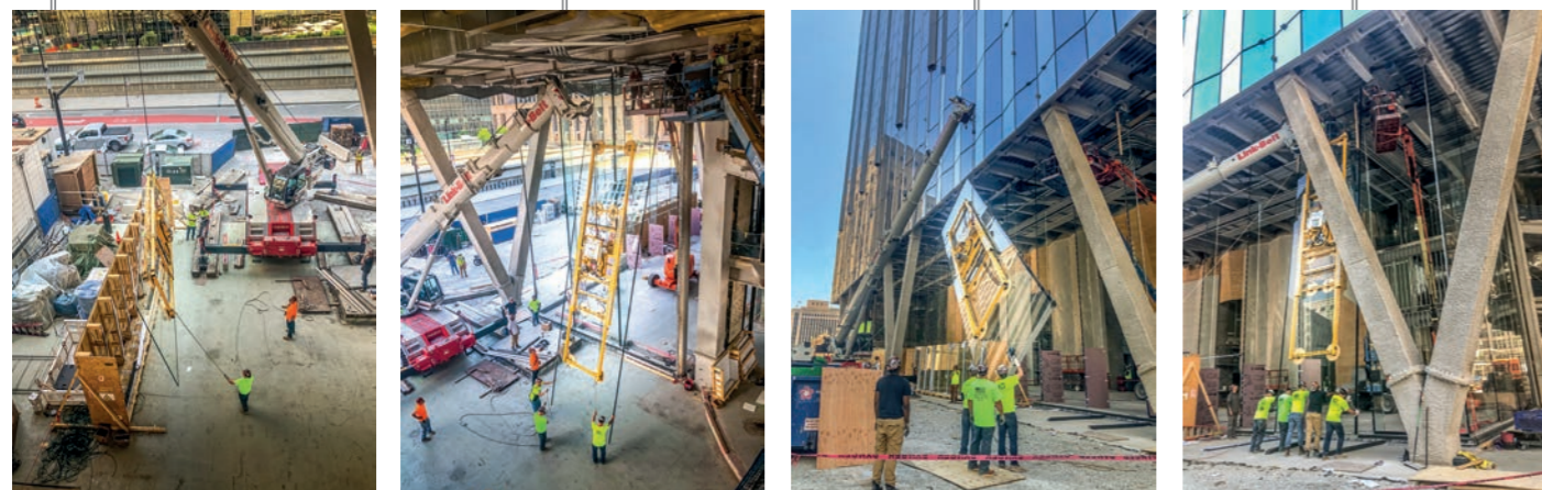
Elementul de sticlă este ridicat în spatele coloanei cu o instalație de montare a sticlei modificată
