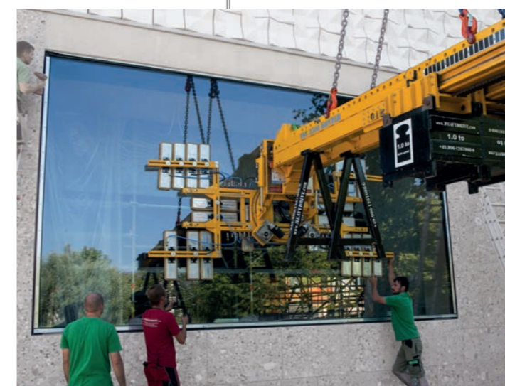
Montare exactă a panourilor de sticlă XXL
