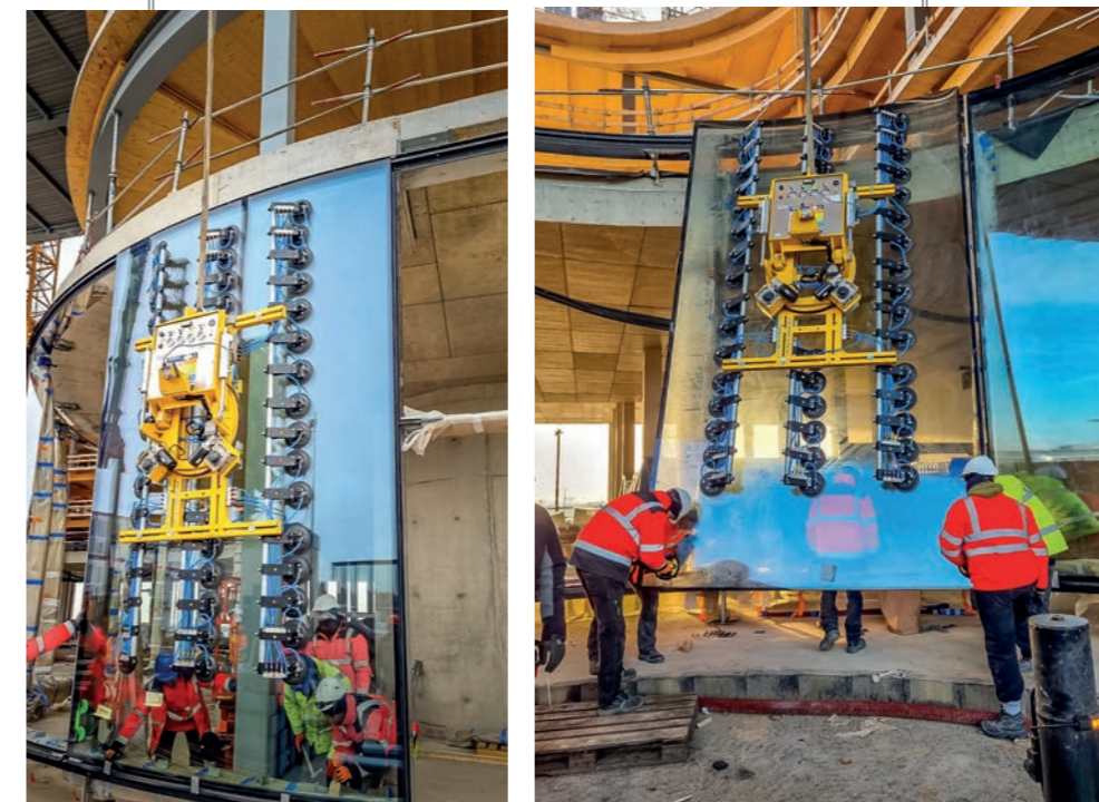
Montarea unor panouri de sticlă curbate cu echipamentul de ridicare cu sucțiune
