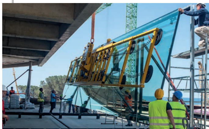
Instalația de sucțiune vacuumică VSG 6000 KMH cu un panou de sticlă cu o lungime de 15 m.
